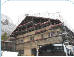
Winter 2014: Die Volksschule im Gerüst. Komplizierte Verhandlungen mit Denkmalmamt und Förderstellen plagten den Gemeinderat. Der Unterricht wurde ins Gemeindeamt verlegt—eine Herausforderung für alle Beteiligten.
